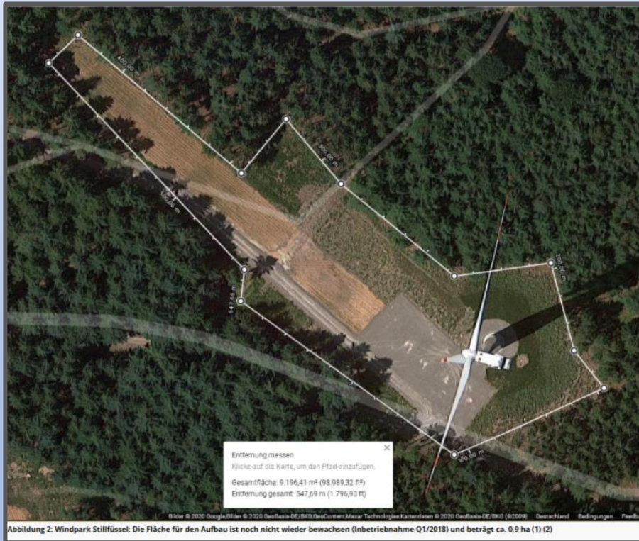
Abbildung 2: Windpark Stillfüssel: Die Fläche für den Aufbau ist noch nicht wieder bewachsen (Inbetriebnahme Q1/2018) und beträgt ca. 0,9 ha (1) (2)
